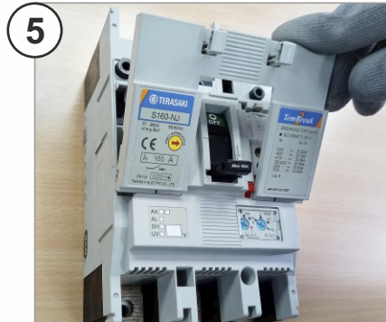
5 Con los accesorios instalados, se cierra la tapa
